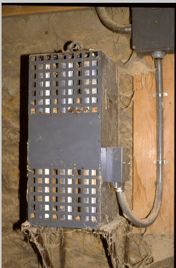
Condensateurs dans une cave Compensation dans une menuiserie
