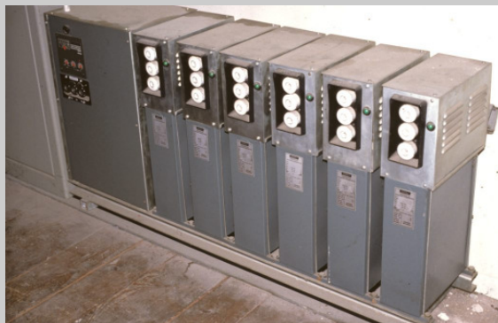
Groupe de condensateurs protégés individuellement
