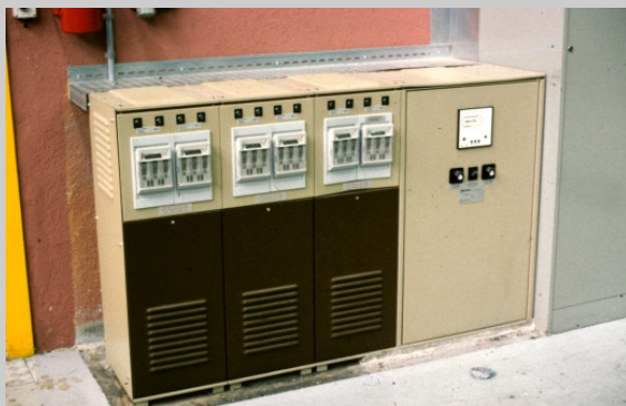
Installation de compensation autonome Peut se trouver dans n'importe quel local
