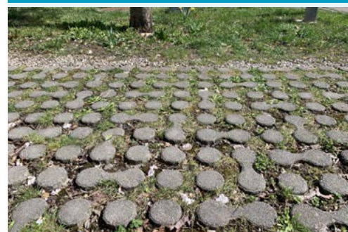
Remplacer les places de parc imperméabilisées par du gravier concassé, du gazon stabilisé ou des grilles gazon.
